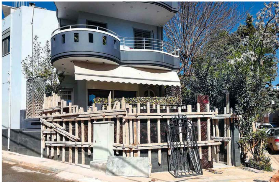
Τέσσερις μήνες μετά την καταστροφή, οι κάτοικοι της Μάνδρας επισκευάζουν τις ζημιές ή, όπως στη φωτογραφία, «θωρακίζουν» τα σπίτια τους.
